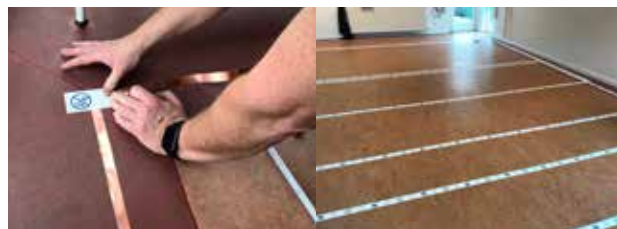
Montering af nyt udstyr.
